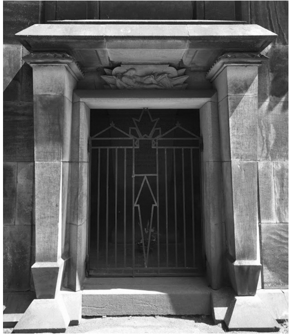
Abb. 13: Hanns Petschke (Zuschreibung), Portal der Gruft-halle für den Besitzer des Färbereibetriebs Kelling (umgewidmet: Richard und Walburga Baehr) auf dem Taucherfriedhof in Bautzen, Sandstein, Eisen, 1926
