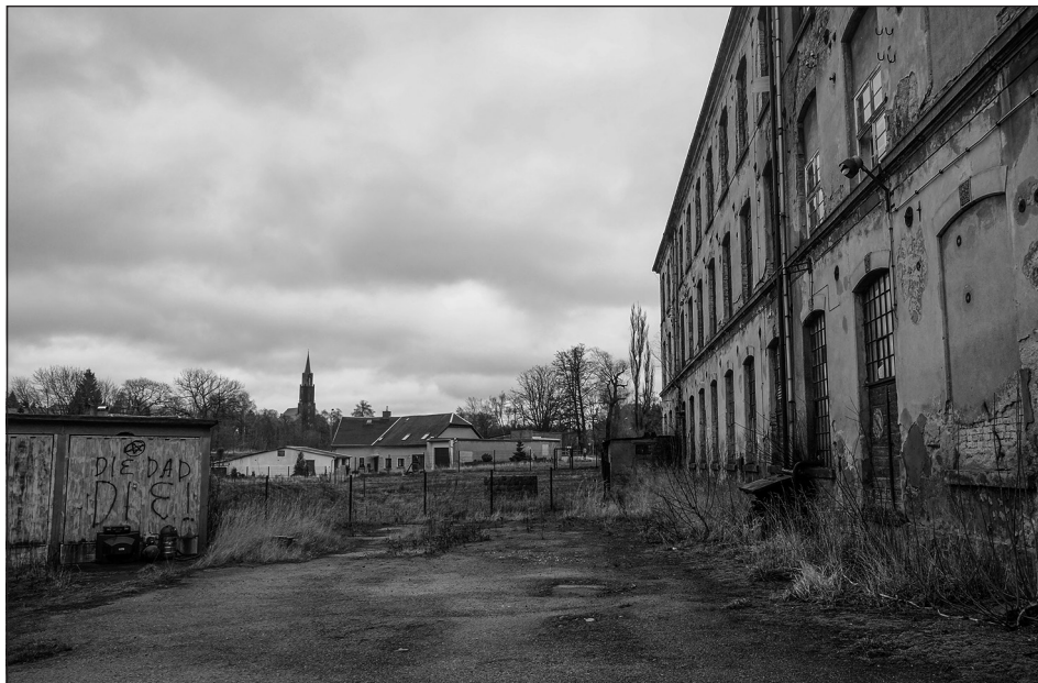
Abb. 4: In seinen (ehemals) industriellen Bereichen wird Neugersdorf vielfach von Brachen geprägt. (Januar 2016)
